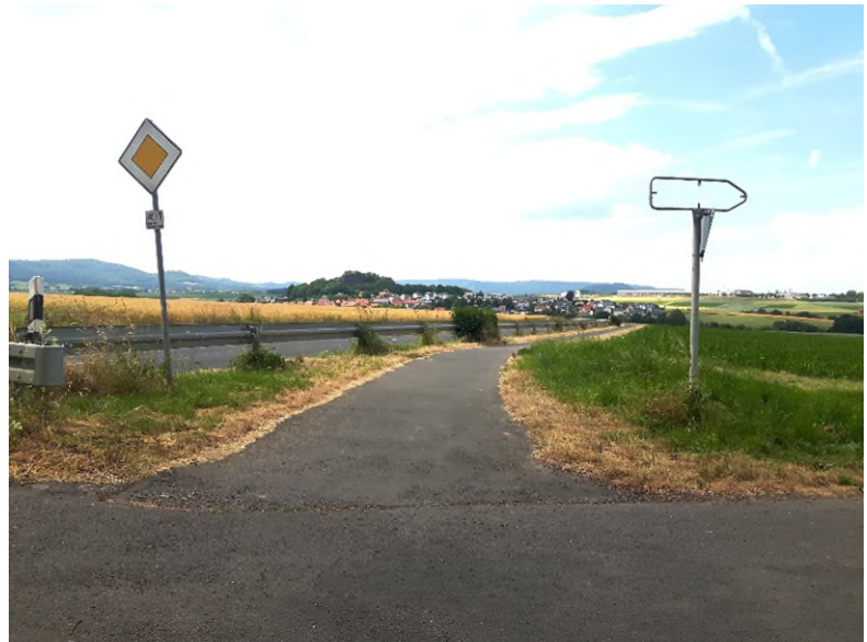
Abbildung 11: Kreisstraße und Radweg mit Gras-Seitenstreifen, Blickrichtung Norden
